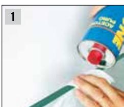
Nettoyage de la surface en verre avec l'acétone ou l'alcool isopropylique.
