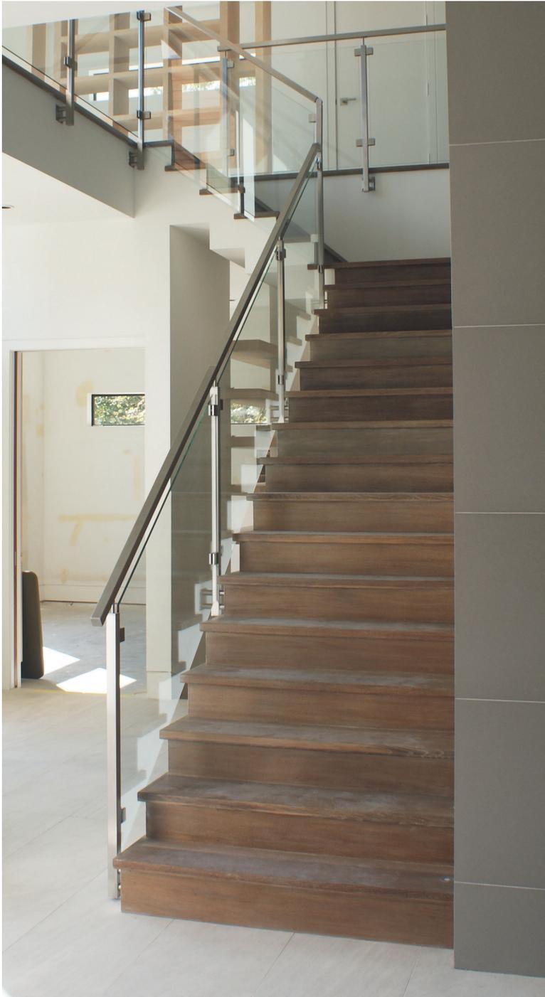
Die Systeme Glass 2S ermöglichen die Herstellung von Glasbalustraden mit quadratischen Pfosten durch Verwendung von Klemmhalterungen, die dank der austauschbaren Gummidichtungen an die verschiedenen Glasdicken angepasst werden können.
